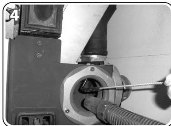
**N.B. En cas d'inspection du conduit de raccordement des fumées en aval de l'extracteur, il est conseillé d'y accéder pour procéder à un nettoyage de la suie et de la cendre.**
